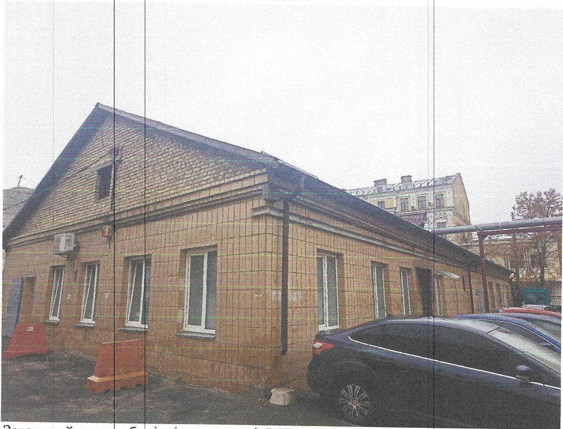
Фото 1. Загальний вигляд будівлі патанатомії КНП «Клінічна лікарня №15 Подільського району міста Києва» виконавчого органу Київської міської ради (Київської міської державної адміністрації), що розташована за адресою: м. Київ, вул. Григорія Сковороди, буд. 2.
